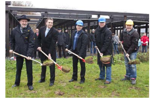
Spatenstich fürs neue JCB-Dojo v.l. Hubert Kohlhepp (2. Vors), Daniel Rommel (Sparkasse), Uwe Careni (1. Vors.), Jürgen Kessing (OB), Markus Gruber (Architekt)
